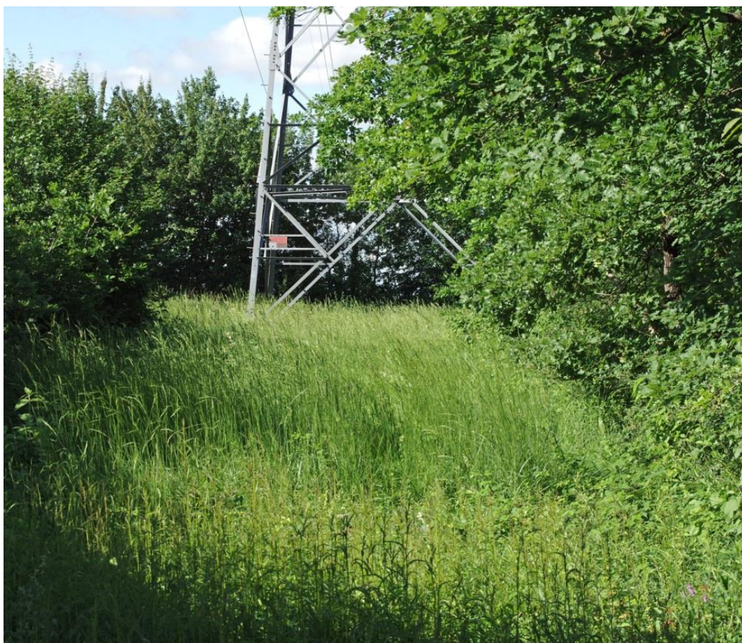
Pelouse-ourlet thermophile autour du pied d'un pylône haute tension (angle de la Chênaie de Rochefort, 21/06/2016)
